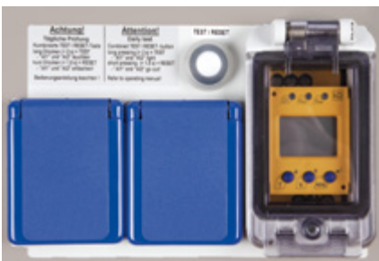
Abb. 11 IMD mit Prüftaste und zugeordneten Steckdosen
