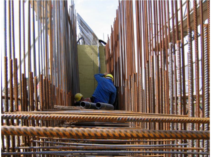
Abb. 19 Beispiel für erhöhte elektrische Gefährdung
