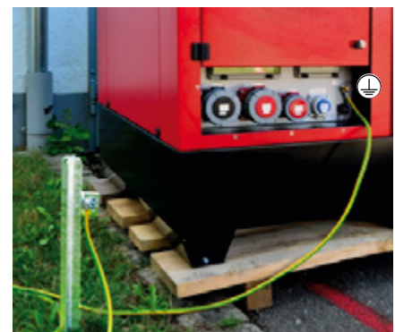
Abb. 15 Stromerzeuger mit Erdungsanschluss und Erdspieß
