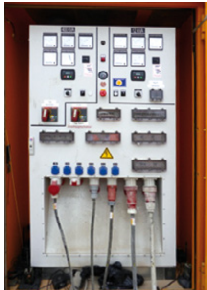
Abb. 14 Anschlussfeld eines Stromerzeugers mit integrierten RCDs
